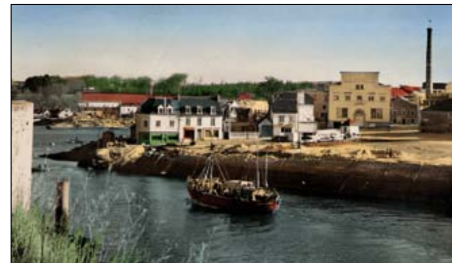
Construction du perré au Passage en 1953
